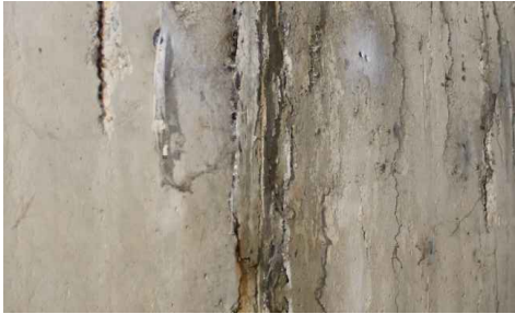
Fotodokumentace – spáry mezi prefabrikovanými propustmi
