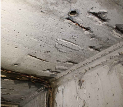
Fotodokumentace – příklad poškození mocnost < 20 mm
