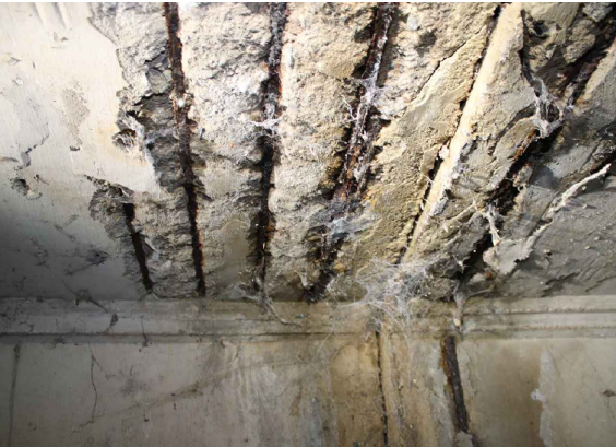
Fotodokumentace – příklad poškození mocnost > 20 mm, výrazné poškození výztuže
